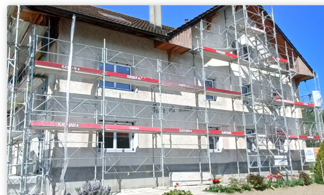
Rénovation totale d'un bâtiment à Avry-devant-Pont
